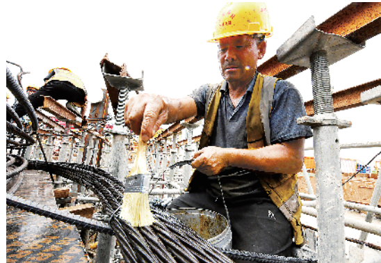
工人为钢筋刷防锈剂。
