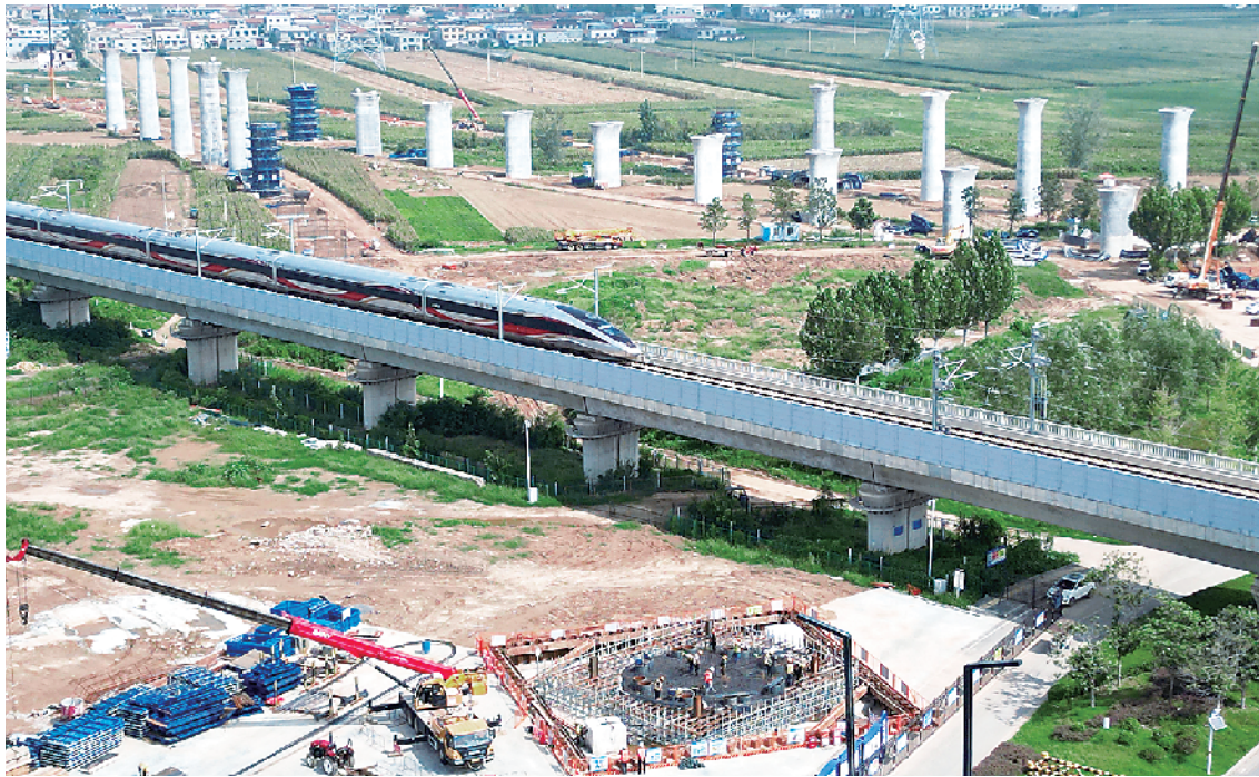
跨郑阜高铁的平漯周高铁转体桥施工现场。
