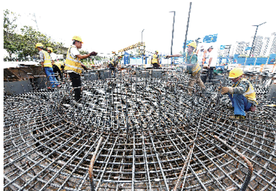
工人在扎桥墩笼子。
