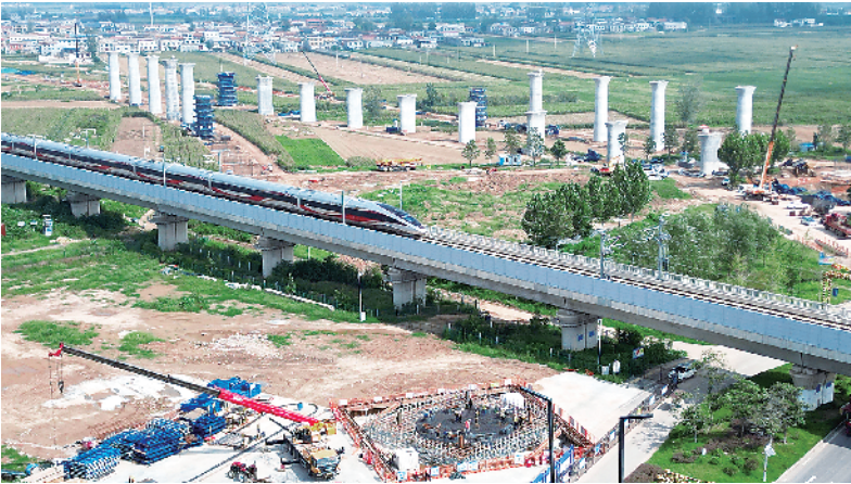
9 月 15 日上午，中铁十局的工人正在安装转体桥上承台钢筋，为浇筑做准备。位于周口太清路的平漯周高铁转体桥经过 5 个月的地下基础施工，目前转入地面以上桥墩结构施工。该转体桥长 200 米，上跨郑阜高铁和太清路，是平漯周高铁全线工程中跨路最多、箱梁最长、施工难度最大、技术要求最高的转体桥。 记者 梁照曾 摄
